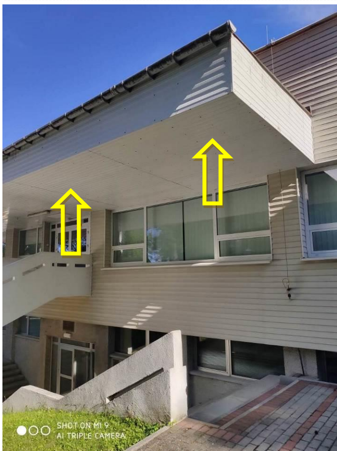
Zdjęcie nr 18 – Zadaszenie od strony południowej przeznaczone do rozbiórki
