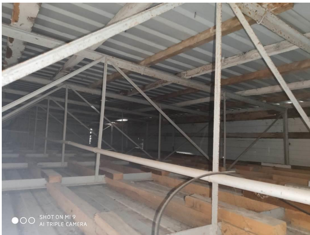
Zdjęcie nr 19 – Konstrukcja zadaszenia od strony południowej przeznaczona do rozbiórki
