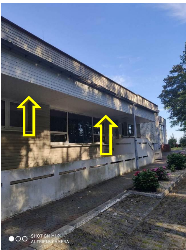
Zdjęcie nr 17 – Zadaszenie od strony wschodniej przeznaczone do rozbiórki
